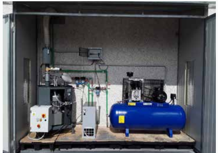
Gescheiden zijkanaalventilator in technische omgeving Separated side channel blower unit in technical environment
